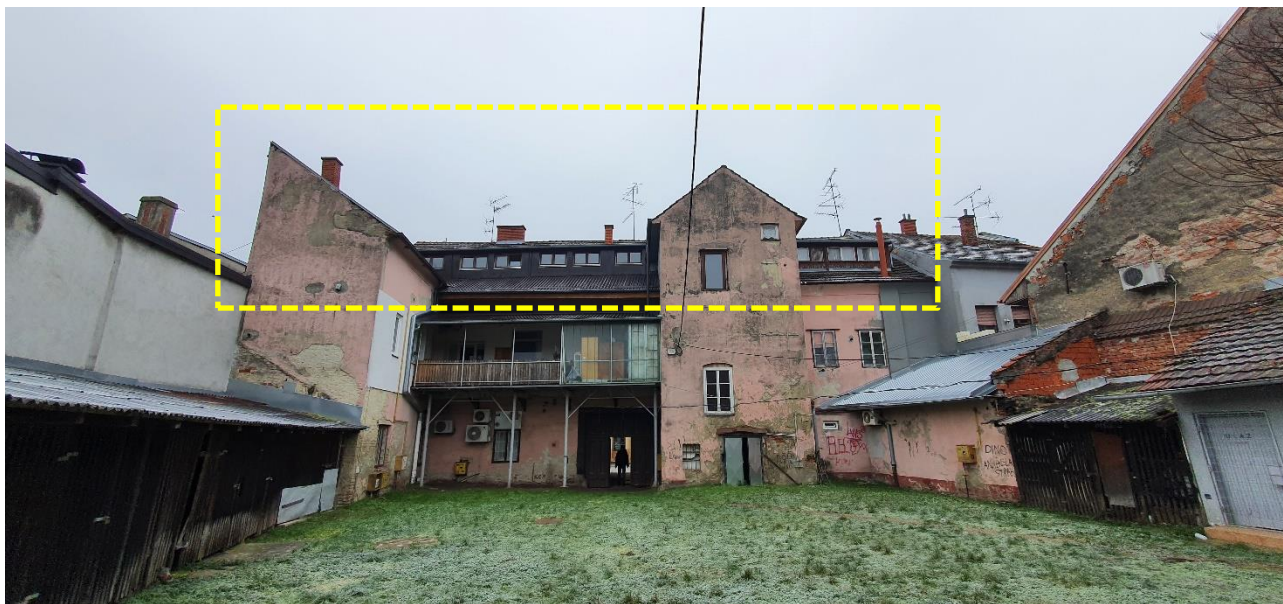
Fotografija 13. Područje zahvata privremenog podupiranja (drvena nosiva konstrukcija krovišta)
