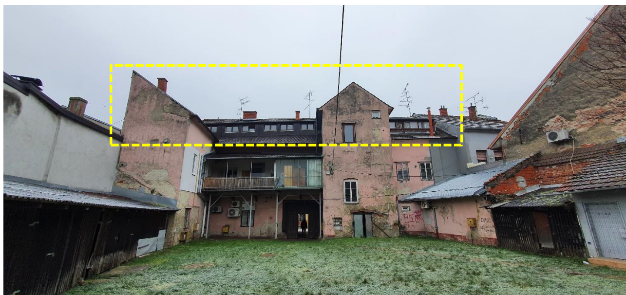
Slika: Područje zahvata privremenog podupiranja (drvena nosiva konstrukcija krovišta)
