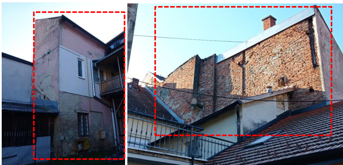
Slika: Zablatni zid sa sjeverne strane i vanjski nosivi zid s istočne strane u dvorišnom dijelu zgrade
