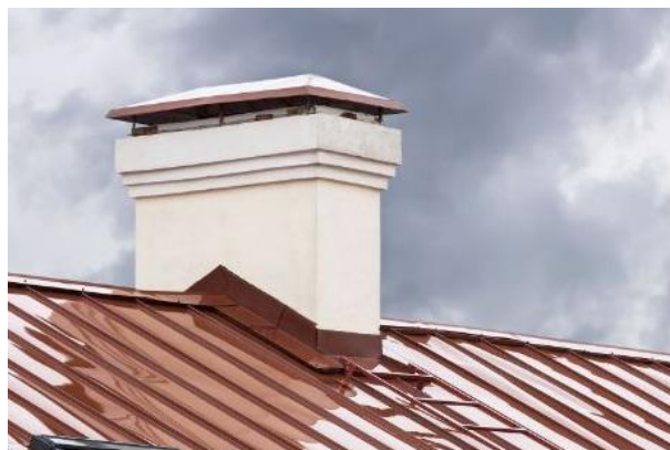
Slika: Falcani čelični lim visine 30 mm i opšav dimnjaka
